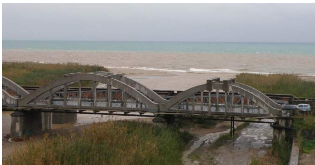
Litorale Ionico: effetti di un nubifragio su terreni in pendio
